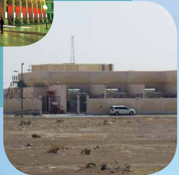
Al Ain Substation (UAE)
